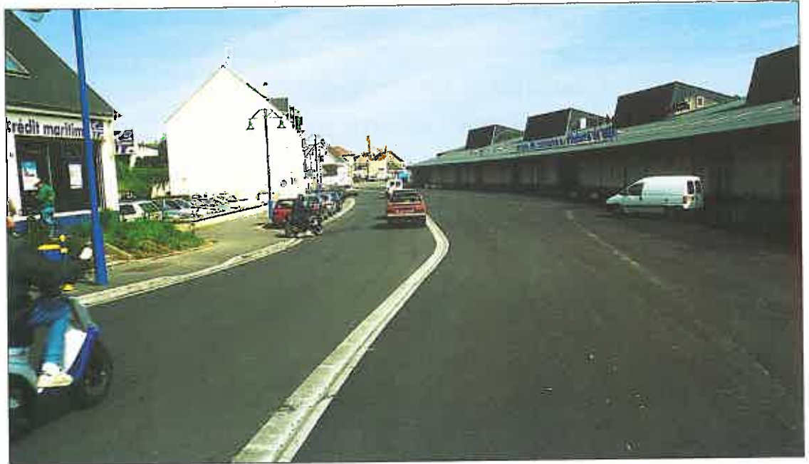
L'aménagement de la voirie et des trottoirs du Quai de Gaulle.
