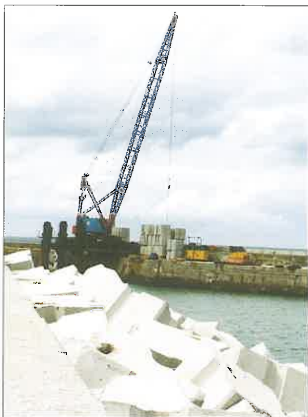
Mise en place du bloc de béton pour protéger les digues.
