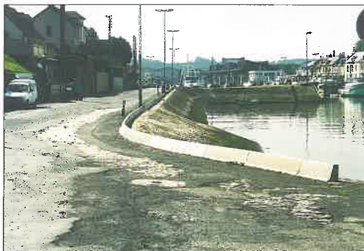
Pose d'un chasse-roue pour la sécurité du port.
