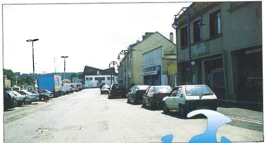
Les nouveaux trottoirs du Quai des Chantiers et l'aménagement du marché hebdomadaire.
