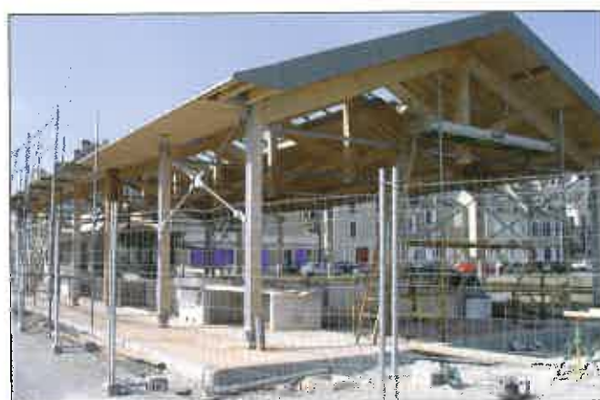
Les travaux de charpente.
