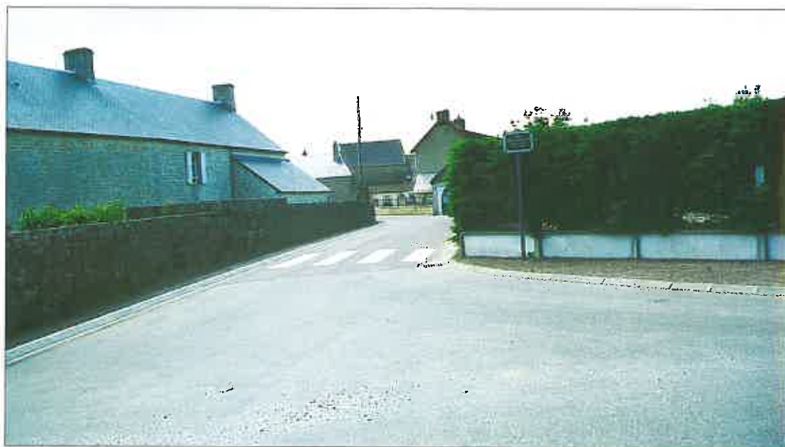
Les travaux de voirie, rue Abbé Lemazurier à Huppain.
