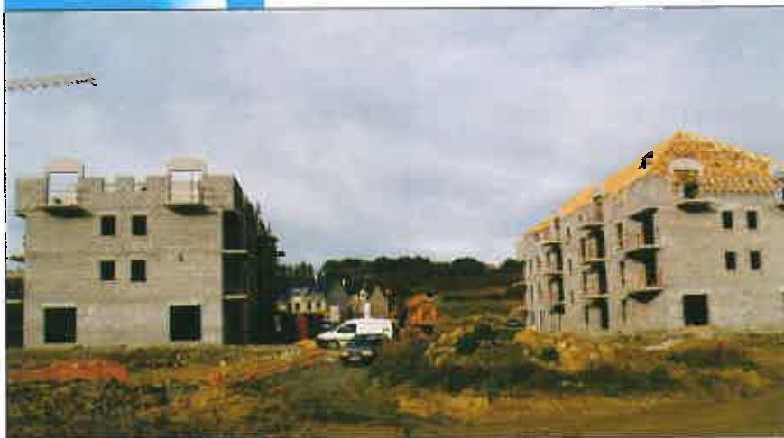
Les constructions sont déjà sorties de terre pour Nexity Georges V
