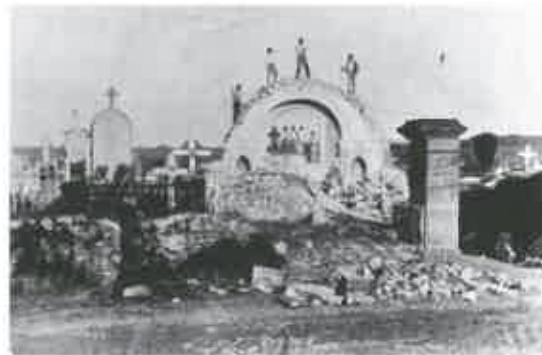
L'église en cours de démolition. Epreuve photograph. sur papier, 1891 (A. paroissiales Port-en-Bessin : Arch. photog., Album n°1) Repro Inv. J.C. JACQUES 91.14.2623.X, 92.14.0020.XA, 0021.XA
