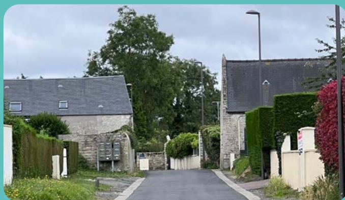
effacement des réseaux aériens rue de Villiers
