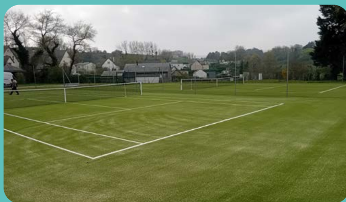
réfection des terrains de tennis
