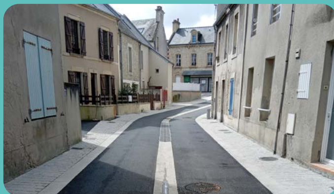
réfection de la rue Nationale
